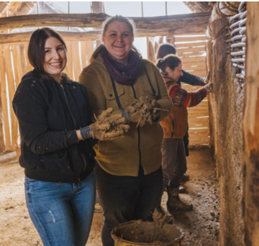
Freiwillige helfen bei der Errichtung einer Häuserwand. Volunteers help build a house wall.
