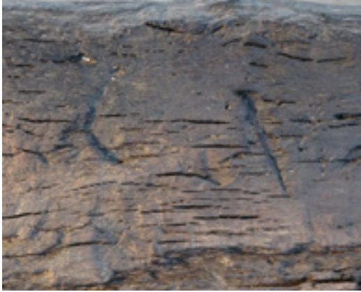
Werkzeugspuren, links: Schlagmarke einer Axt, rechts: längliche Rille. Tool marks, left: axe mark, right: elongated groove.
